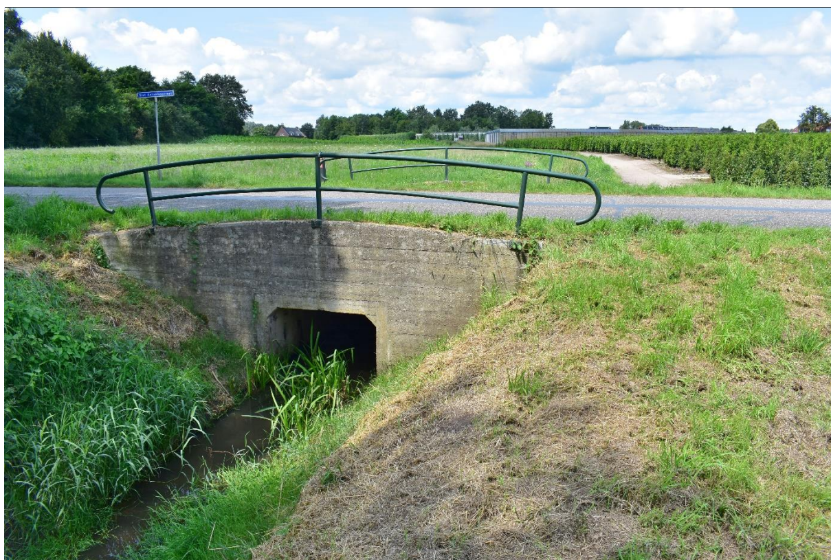
Brug in de Sint Antoniusstraat over de Bevelandse Beek.
