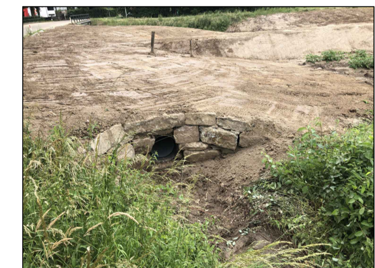
Referentie foto : Stapelwerk rondom duiker
