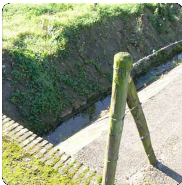
Begin overkluizing Luiperbeek
