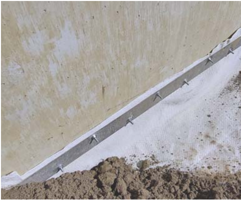
Figuur 13 – Detail klemconstructie bentonietmat met metalen strips, uitgevoerd bij betonnen inlaatwerken in de dijk.
