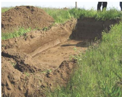
Figuur 15 – Proefsleuf en opgraven bentonietmatten bij de Elbe dijk Wittenberge vanuit BAW Duitsland.
