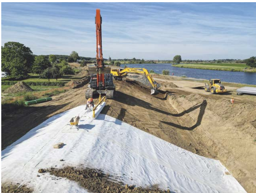
Figuur 12a en b – Aanbrengen bentonietmatten op de dijk en uitrollen hiervan met behulp van een evenaar.
