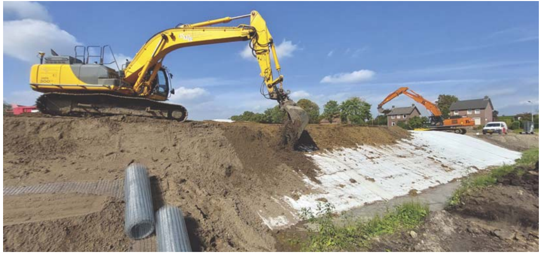
Figuur 14 – Afdekken bentonietmatten met grondlaag en aanbrengen van bevergaas als maatregel tegen dierlijke graverij dijkvak Beesel.
