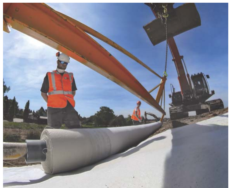
Figuur 12a en b – Aanbrengen bentonietmatten op de dijk en uitrollen hiervan met behulp van een evenaar.
