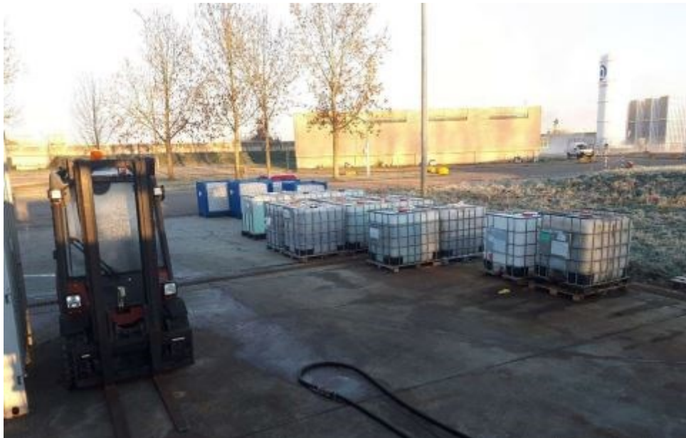
No 12: opstelplaats multiboxen
