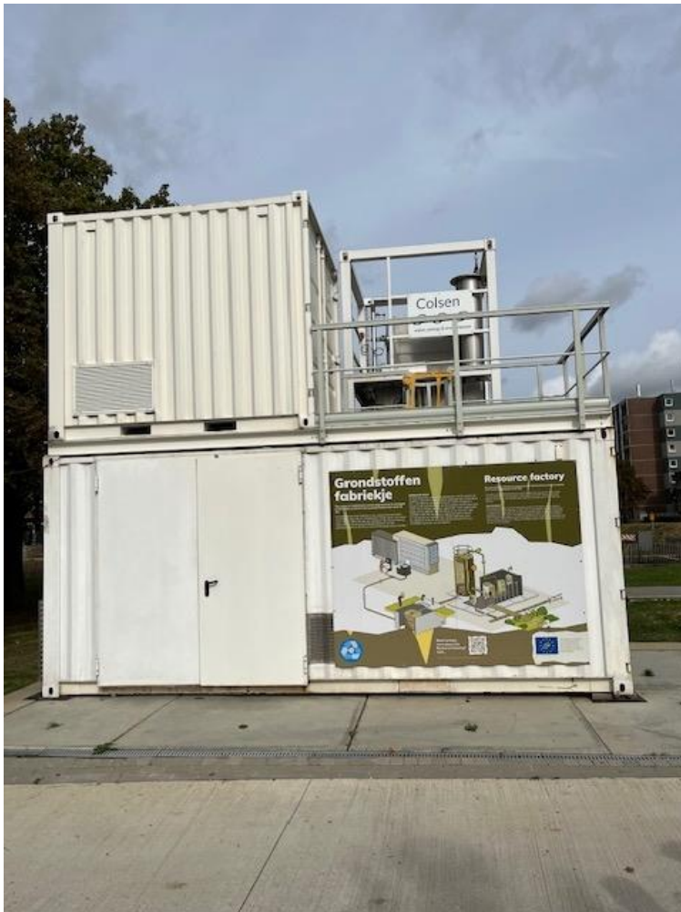
Figuur 46: Vacuümstation met vergister voor behandeling zwart water
