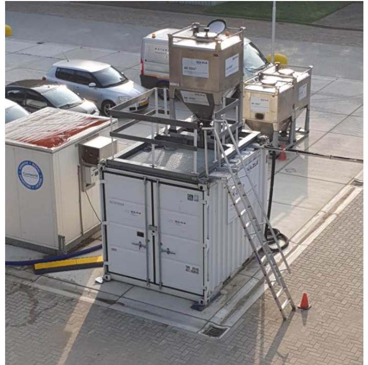
Figuur 42: Poederkoolinstallatie op RWZI Simpelveld
